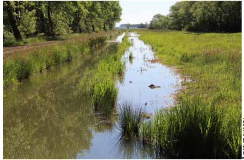
Inrichting van paai- en opgroeiplaats voor vissen langs bestaande sloot.
