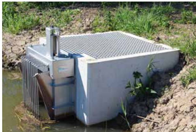
Aanleg van vijf aangepaste De Wit-vispassage naast de bestaande stuwen om zo vissen via de verschillende peilvakken te kunnen laten uitwisselen tussen Pompveld-Oost en Andelsch Broek (ontsnippen van peilvakken). Tevens zijn de oude stuwen en pompen verwijderd en werden automatisch werkende stuwen aangelegd om zo het gebied beter te vernatten.
