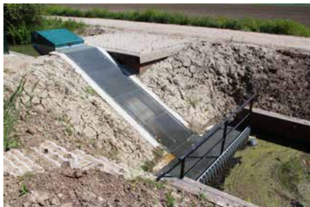
Installeren van een visvriendelijk vijzel gemaal aan de rand van Pompveld-Oost. Hier wordt gebiedsvreemd water ingepompt en kunnen vissen ongeschonden door deze visvriendelijke vijzel het gebied in komen. Het gebiedsvreemde water wordt door het geoptimaliseerde helofytenfilter geleid, waardoor het water op een natuurlijke wijze wordt gezuiverd
