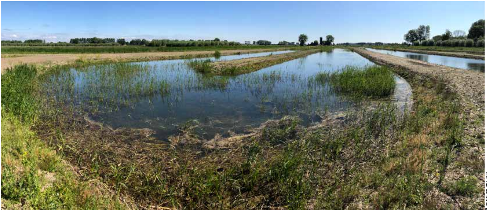
Het helofytenfilter (rietfilter) aan de oostzijde van het Pompveld werd geoptimaliseerd en uitgebreid om de waterkwaliteit te verbeteren. Water uit de agrarische polderwatergangen wordt in de nieuwe situatie met een visvriendelijk vijzelgemaal opgepompt, door het helofytenfilter geleid, om daarna gezuiverd zijn weg door het natuurgebied te vervolgen.
