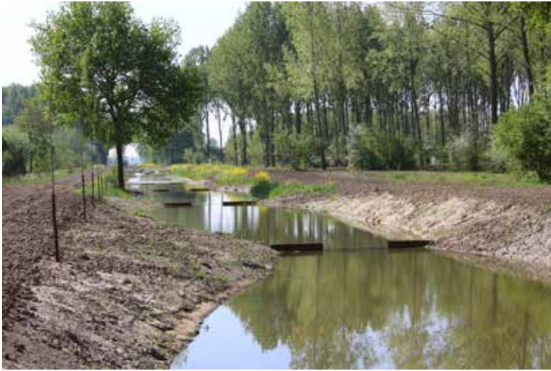
Afkoppelen en verondiepen van de voormalige hoofdwatgang. In het midden-gedeelte zijn twee vistrappen aangelegd om de verbinding voor vissen tussen Pompveld-Oost en Andelsch Broek mogelijk te maken.
