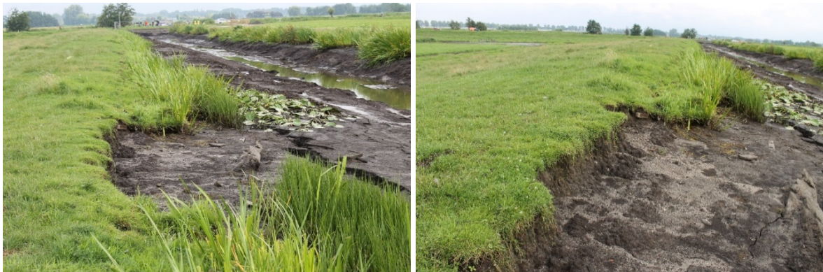
Figuur 14 Voorbeeld van afgetrapte kade oever. In het rechterbeeld zijn de sporen van de koeienklauwen zichtbaar in de oeverrand. Foto: Ivo Roessink©
