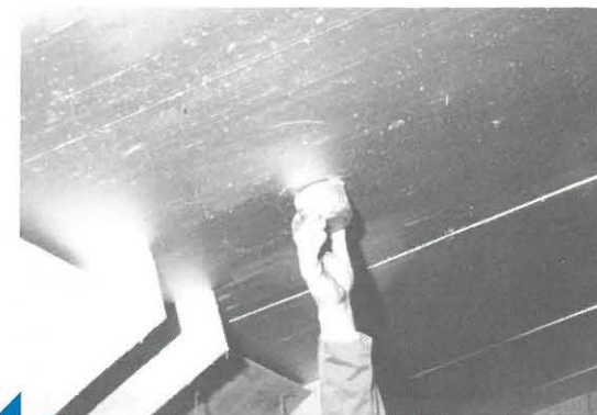
"voerpot in isolatie aanbrengen"
