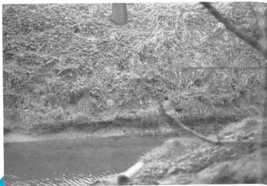
rattenholen in de slootkant
