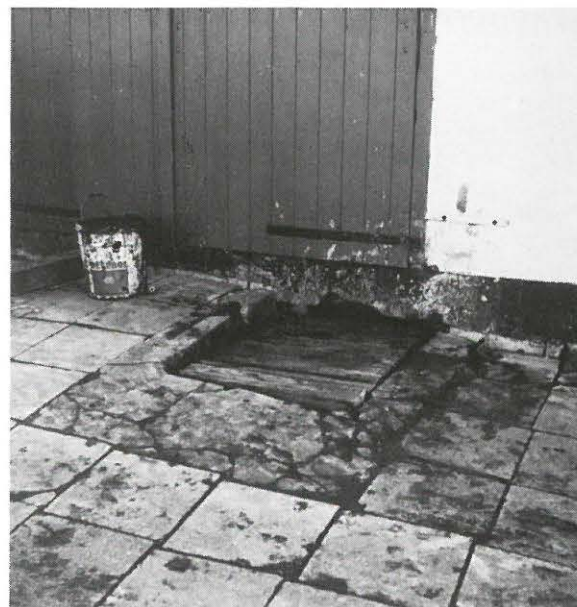
Deksel van afvoerput van metaal maken.
