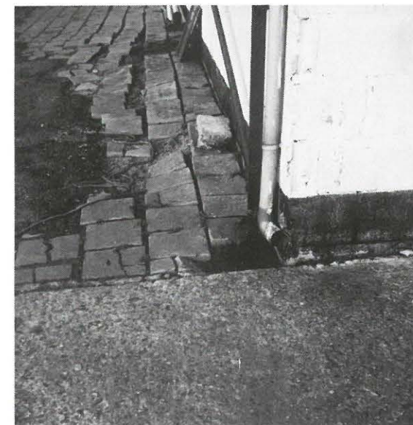
Open regenpijp afsluiten met bolrooster.
