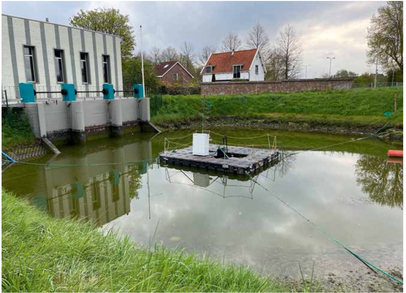
Monitoringmodule bij poldergemaal 't Sas in Zierikzee
