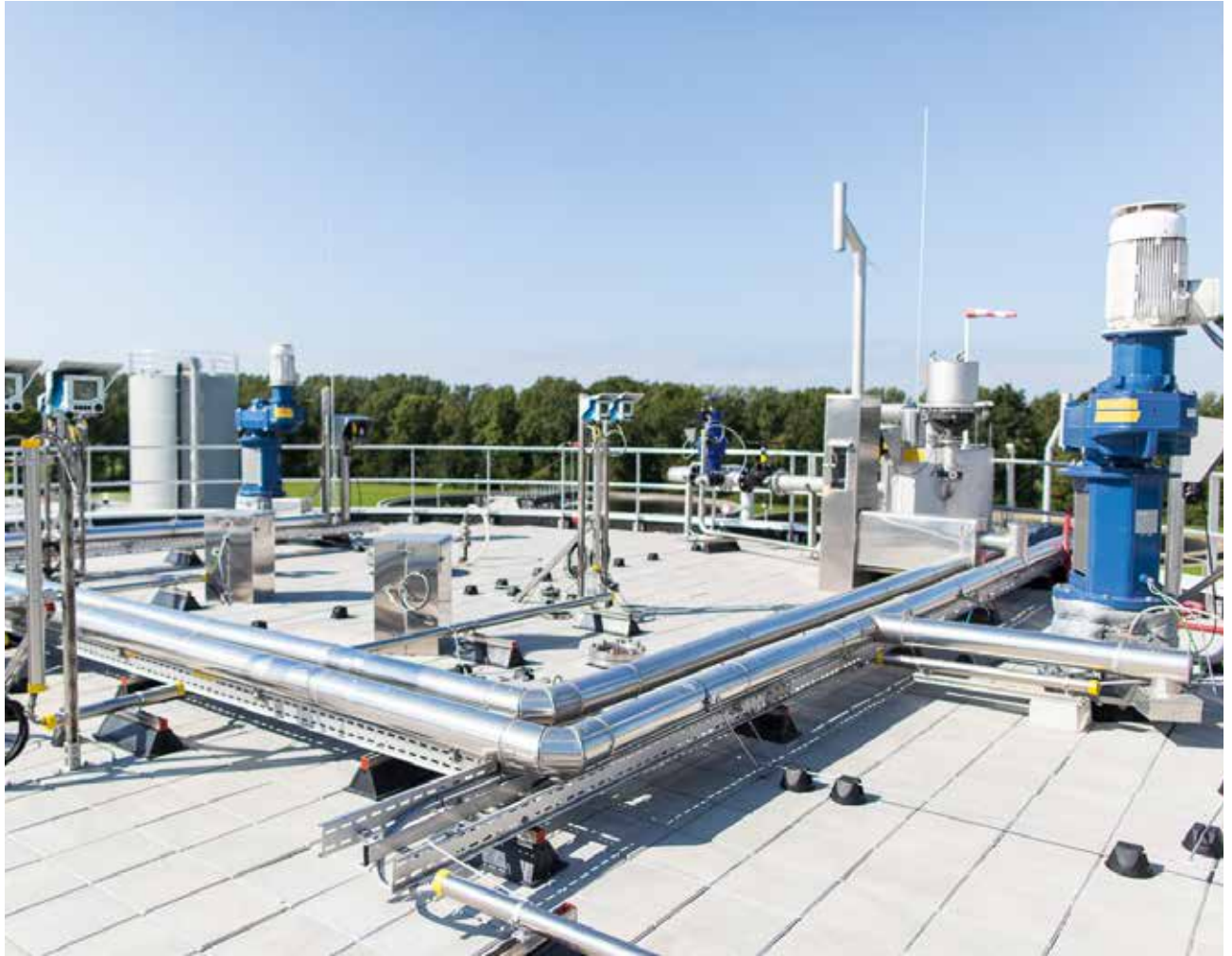
Foto genomen vanaf het dak van de Ephyra-reactor op awzi Tollebeek
