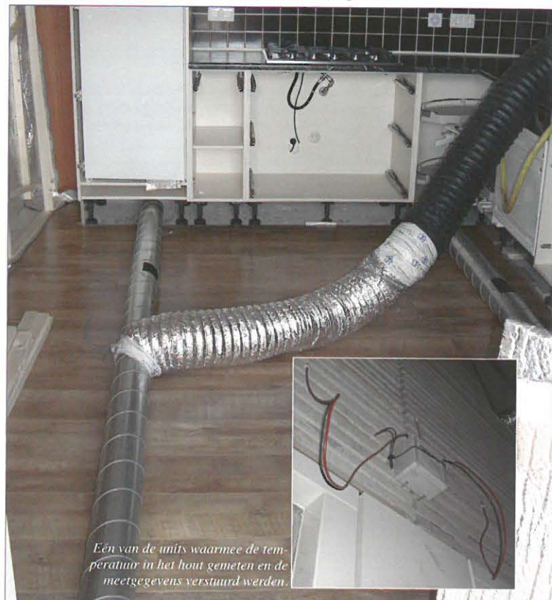
Een verdeelstuk waardoor er hete lucht in de keuken wordt geblazen
