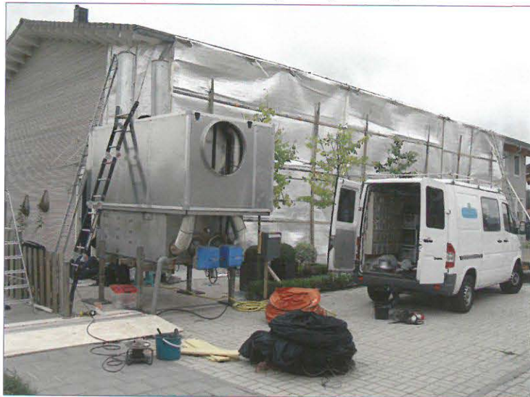
Een verdeelstuk waardoor er hete lucht in de keuken wordt geblazen
