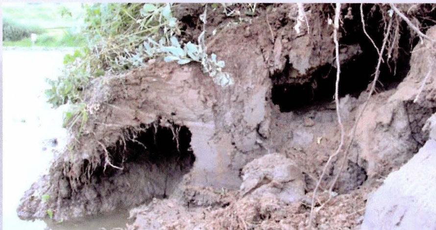
Schade door graverij beverratten.
