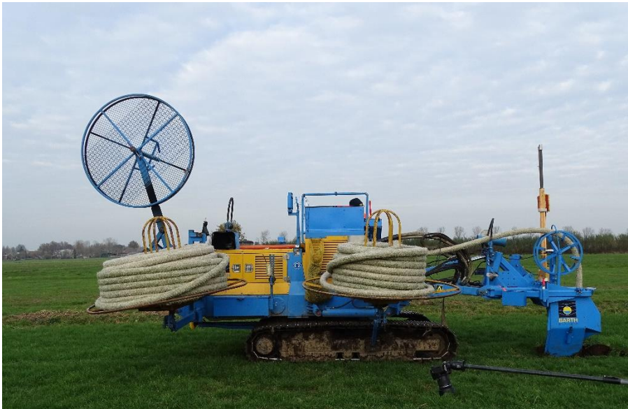
Figuur 3.13 Aanleg drains door Barth Drainage B.V. ten behoeve van het IPV-onderzoek naar de werking van drukdrains.
