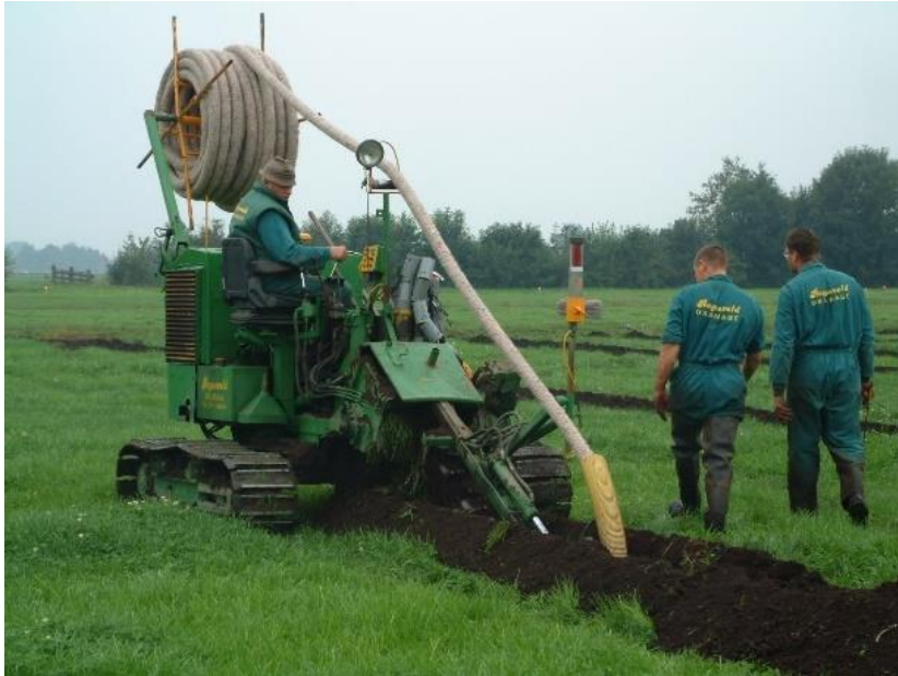
Figuur 3.3 Aanleg buisdrains locatie Zegveld met een kleine kettinggraver (2003).
