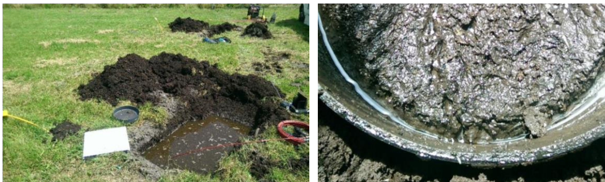
Figuur 5.3 Links: hoge waterpeilen na verwijderen deksel van bezinkput op perceel 14 bij onderwaterdrains op de sloot. Rechts: put gevuld met slib en amper water op perceel 16 bij drukdrains.
