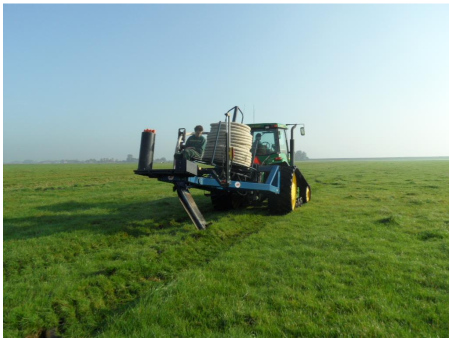
Figuur 3.7 Aanleg sleufloze drainage in de lengterichting van de proefpercelen op locatie Warder door loonwerkbedrijf De Vlijt uit Noord-Beemster.
