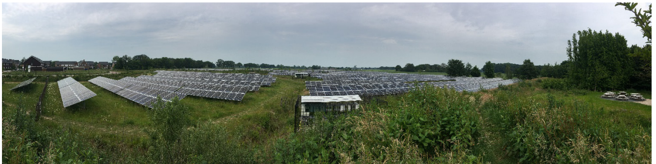
Figuur 3.12 Solarpark Hengelo (Gld). Natuurinclusieve opwekking van duurzame energie (foto: Bas Breman).
