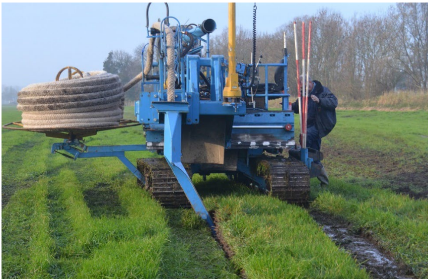
Figuur 2.4 Aanleg drains door Barth Drainage B.V. ten behoeve van het IPV-onderzoek naar de werking van drukdrains.
