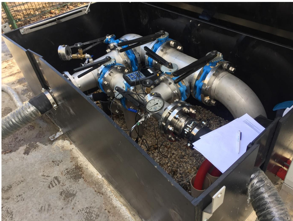
Afbeelding 2. HDPE-kast met handbediende afsluiters
