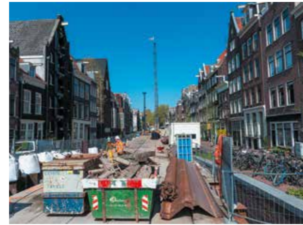
⇒ Restauratie damwanden Amsterdam
