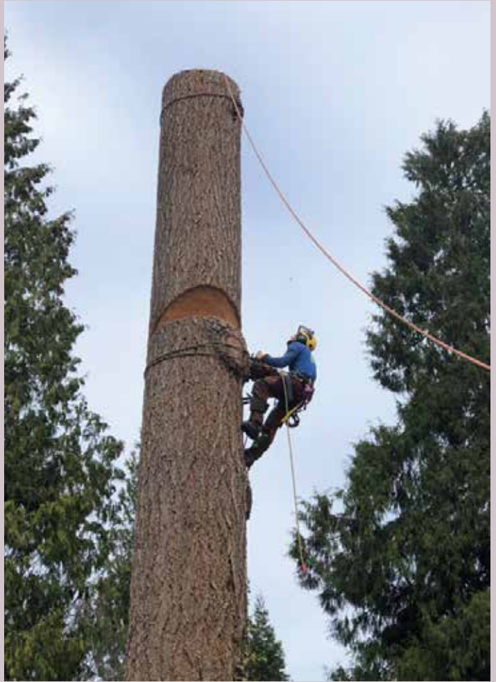
Afbreken van een douglasspar in Campbell River (British Columbia, Canada).
