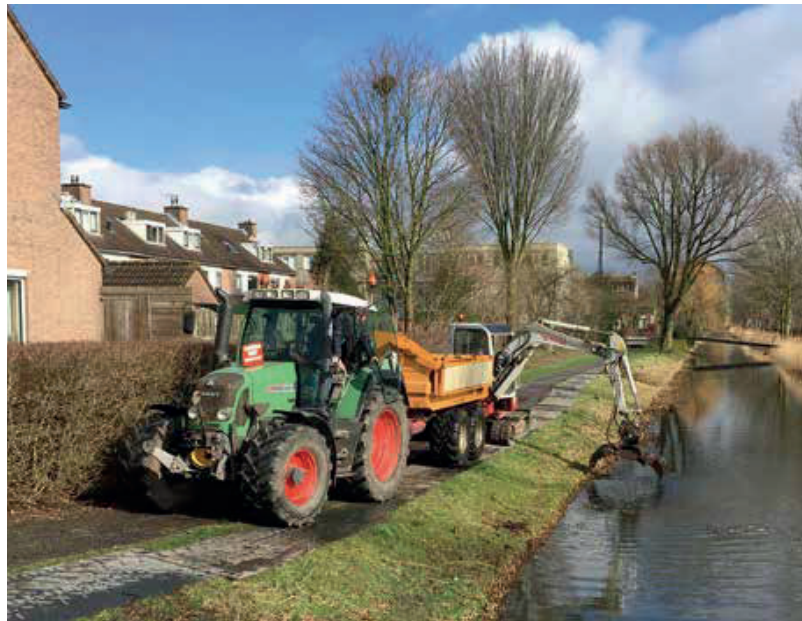
In de wintermaanden is er veel werk aan watergangen en het opknappen en aanleggen van halfverhardingen voor wandelpaden in de omgeving.
