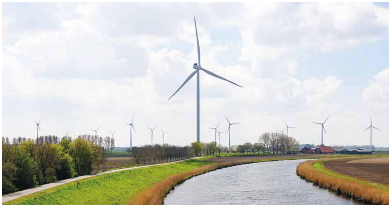
Windmolens langs de Mark in Etten-Leur: op de voorgrond 200 meter hoog, daarachter 100 meter. Foto: Johan Meeus.
