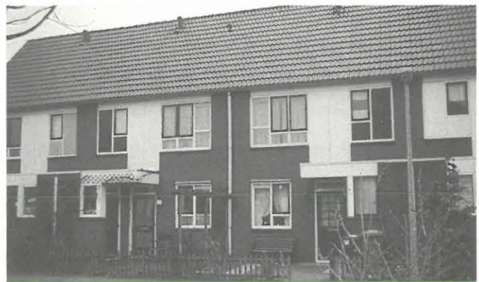
Kolonies van de gewone dwergvleermuis worden vaak in de spouwmuren van vrij nieuwe gebouwde huizen gevonden (foto: P.H.C. Lina)
