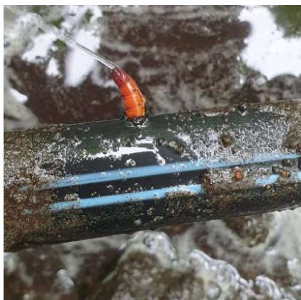
Figuur 21. Schade door ritnaalden
