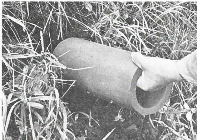
Aanbrengen van de drainbuis
