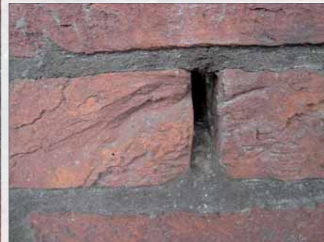
Een opening als deze voldoet wellicht aan de voorschriften van het Bouwbesluit maar volstaat niet om muizen volledig te weren.
