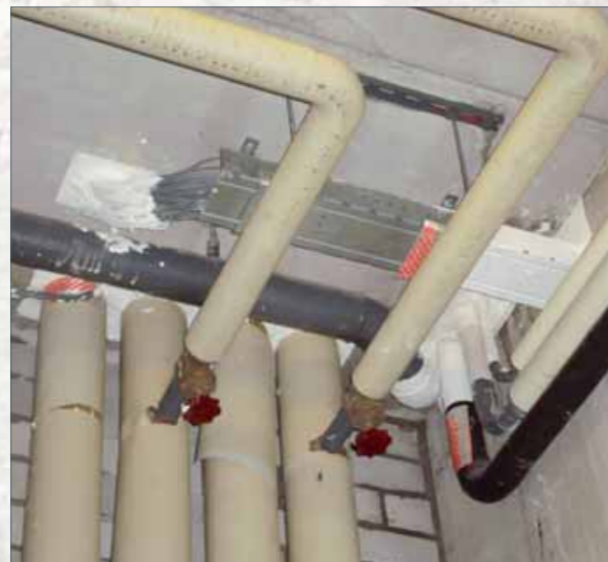
Doorvoeropeningen voor bedrading en leidingen zijn hermetisch afgesloten.
