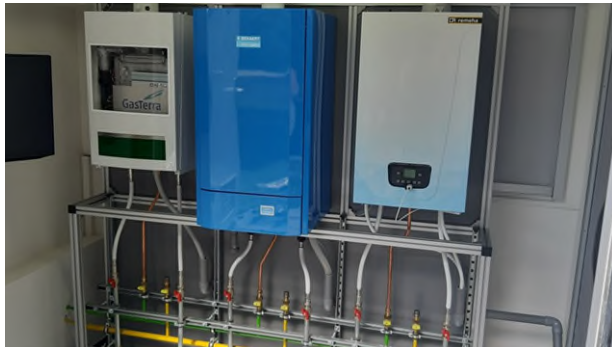
Figuur 3. Stedin experiment met 3 CV-ketels op waterstof, Remeha, Beckaert en Gasterra.
