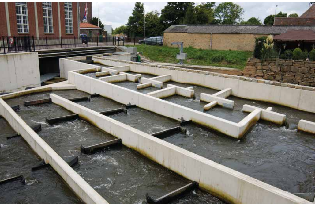
De vertical slot-passage werkt goed voor stroomopwaarts zwemmende vissen.
