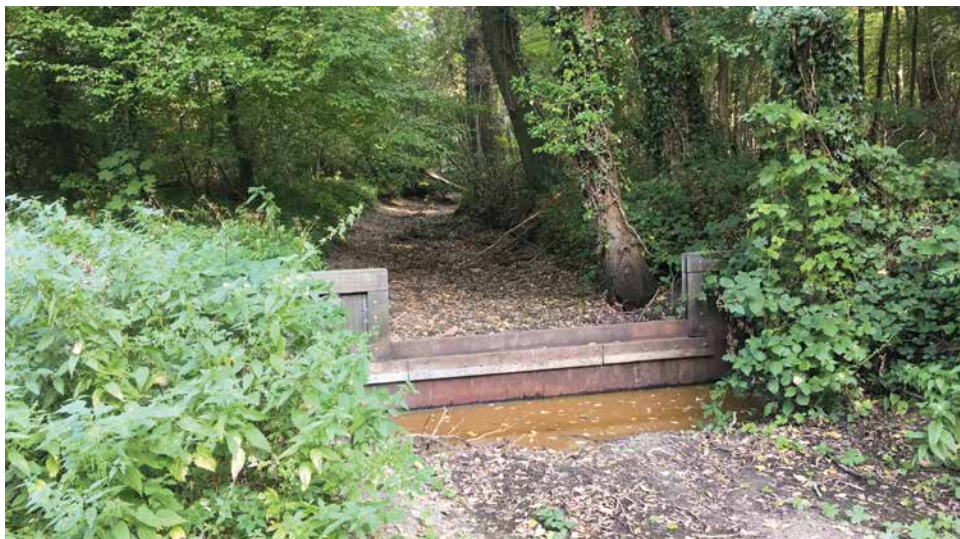
Een stuw in de Bavelse Leij die in een normaal jaar het waterpeil reguleert.
