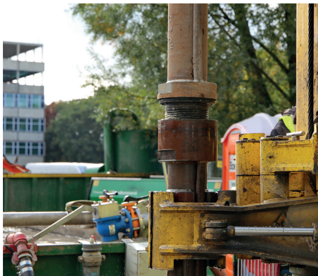
Afb. 3: Boorstangen worden aan elkaar gekoppeld.
