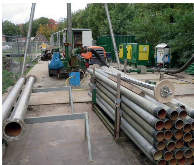
Afb. 8: Opstelling voor het ontwikkelen van de bron, met op de voorgrond het sectieapparaat.
