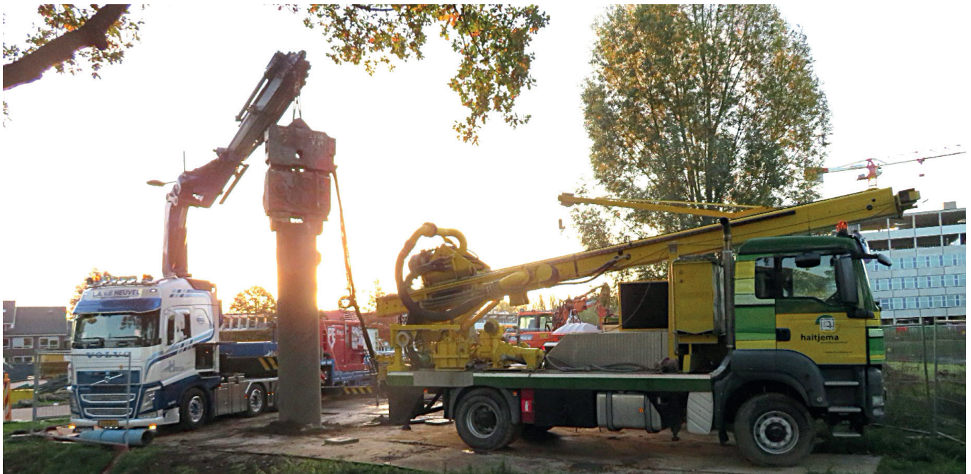
Afb. 1: De mantelbuis wordt ingetrild.
