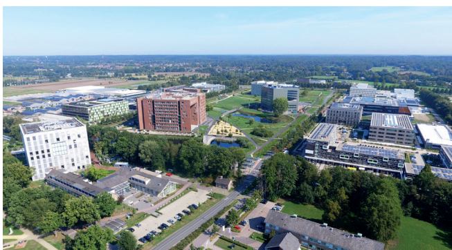
Afb. 4 Het doel is dat over 5 jaar alle gebouwen op de campus zijn aangesloten op de WKO-ringleidingen.
