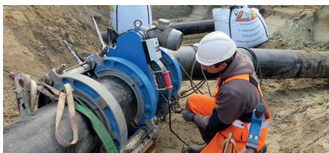
Afb. 5: De hete spiegel wordt tussen de leidingen geplaatst, waarna de leidingen aan elkaar gelast kunnen worden.
