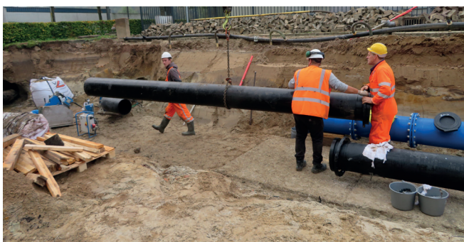
Afb. 3 Met behulp van de kraan worden de leidingen op de juiste plek gebracht.
