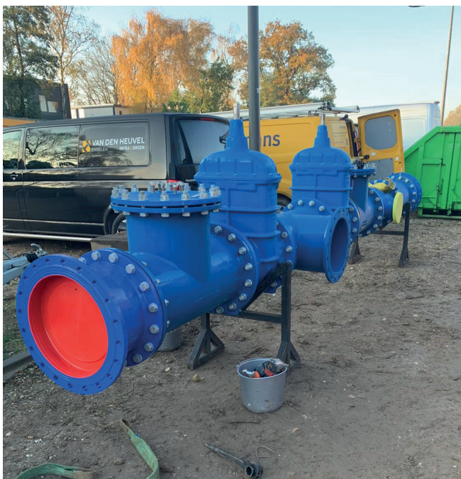
Afb. 1: Op het depot worden de groepen samengesteld. Deze groep weegt zo'n 2200 kg.
