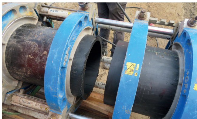
Afb. 4: De leiding uiteindes zijn evenwijdig geschaafd en kunnen nu aan elkaar gelast worden
