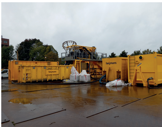
Afb. 2: In de ene bak wordt de bentoniet aangemaakt en de boring in gepompt. Met de machine wordt het uitredende bentoniet-zandmengsel middels schudzeven gescheiden en verspreid over de andere bakken.
