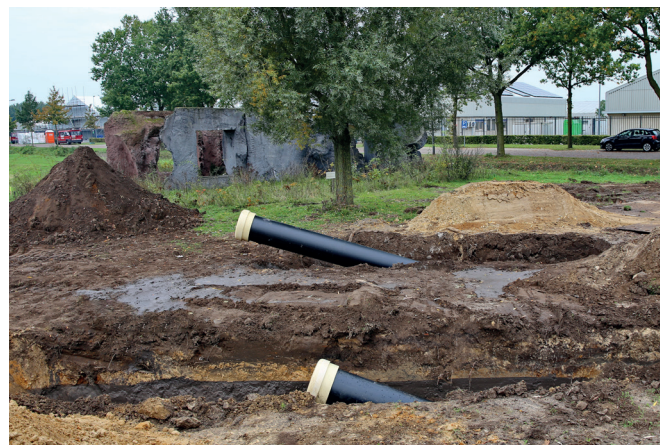
Afb. 8: Twee uittredende leidingeinden in afwachting op de koppeling.
