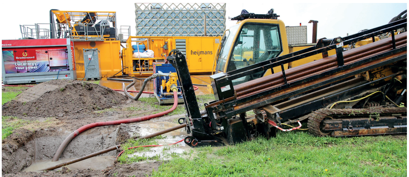
Afb. 1: Booropstellingen bij intredeput. Deze zware machine koppelt automatisch de verlengstangen; bij lichtere machines gebeurt dit handmatig
