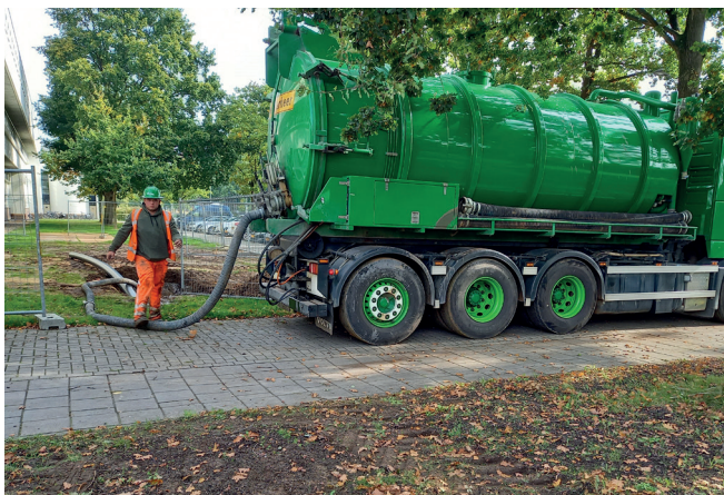
Afb. 7: "Klaar! Het overgebleven bentoniet-zandmengsel wordt afgezogen en afgevoerd."
