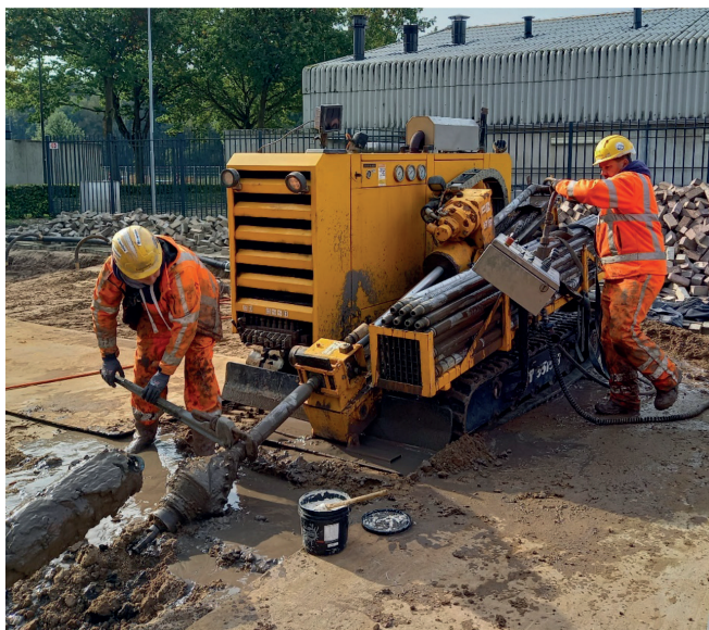
Afb. 4: De ingetrokken leiding is weer boven bij intrede. Dus de trekkop kan er af en de ruimer kan losgeschroefd worden.
