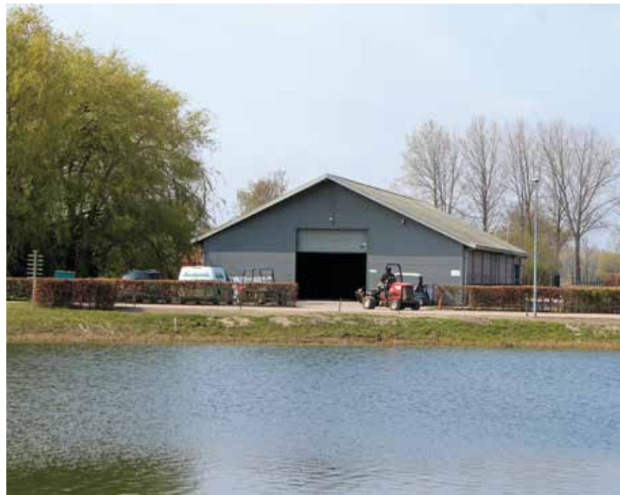
Op de golfbanen heeft Oosthoek een eigen ruimte voor stalling van zijn machines.
