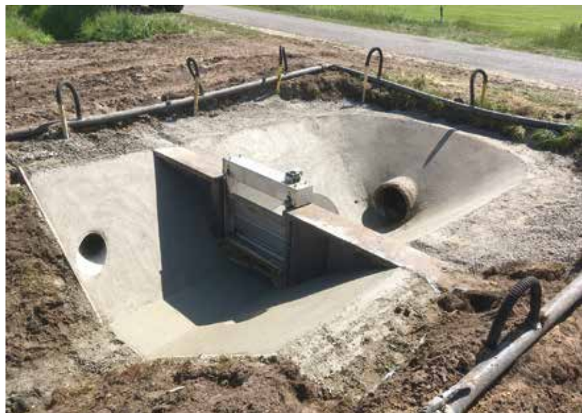
Afgelopen jaar is Egberts betrokken geweest bij het plaatsen van stuwen om meer water vast te kunnen houden.
