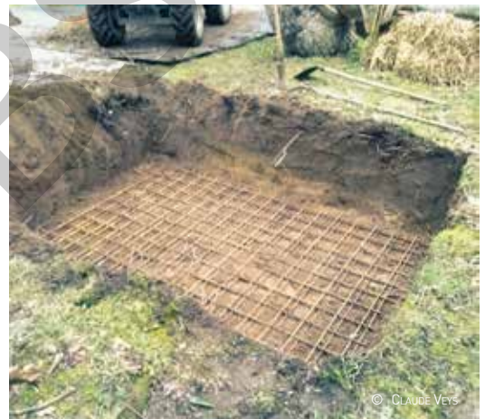
Een wapeningsnet onder de kluit dient om de verankeringsbanden vast te maken.
