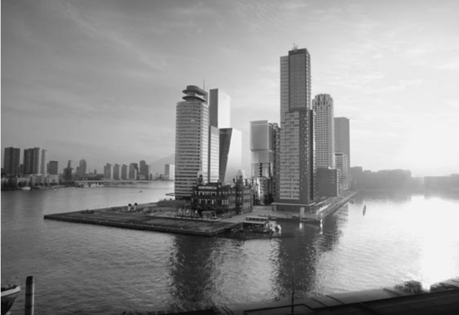
Het waterfront als plek om te wonen: Woontorens op Willeminapier van architect Kees Christiaanse
