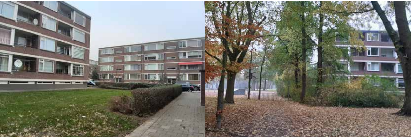
Impressiebeelden Reyeroord. (Fotograaf: Nanda Sweres)
