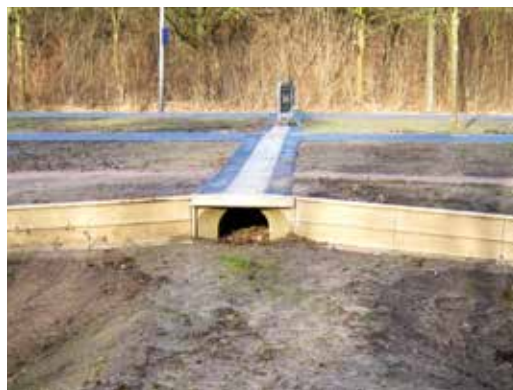
Figuur 4 Twee voorbeelden van kleine faunatunnels in het wegdek (links) of vlak onder het wegdek (rechts).
