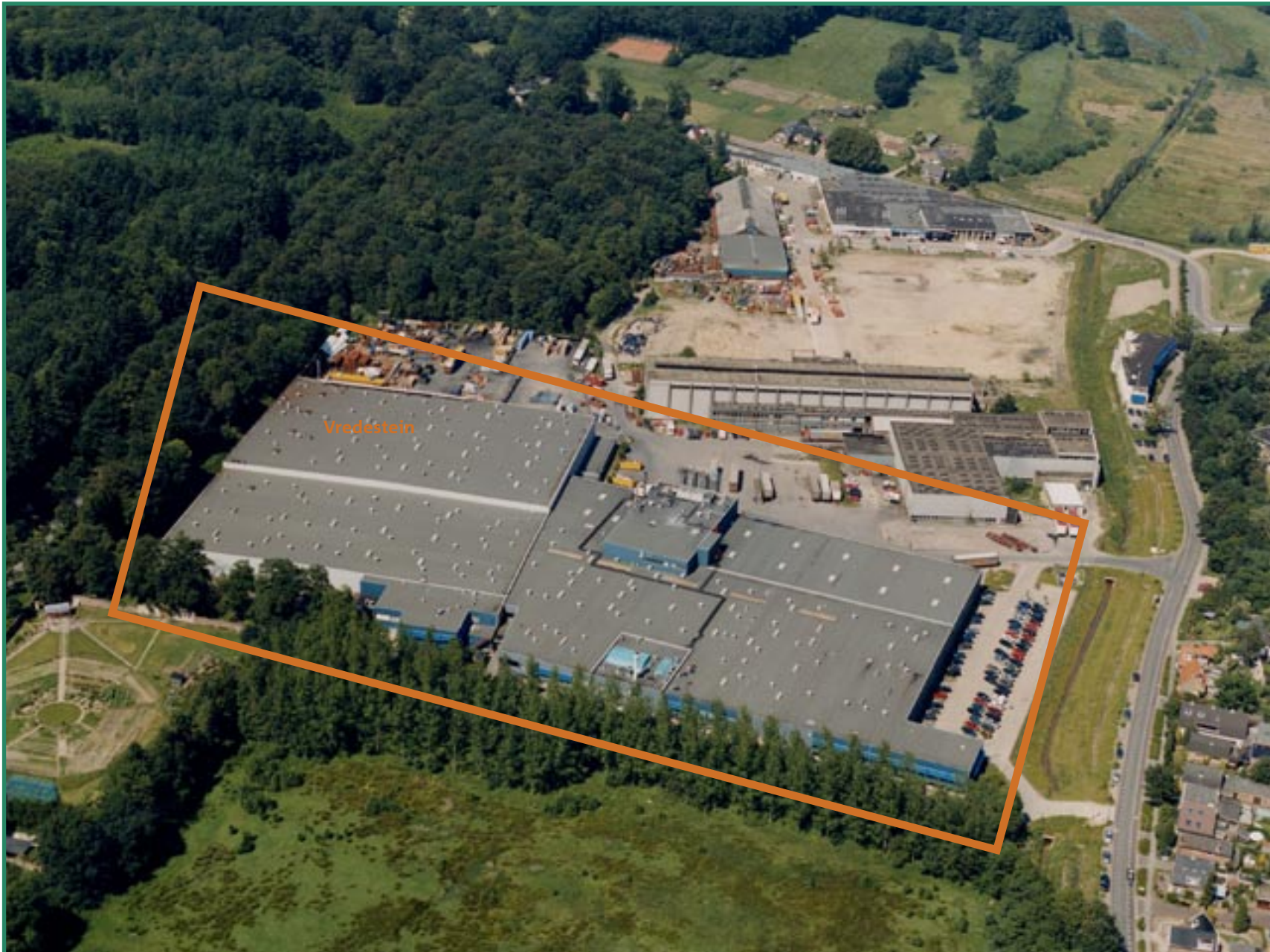
locatie Vredestein (luchtfoto Pandion)
