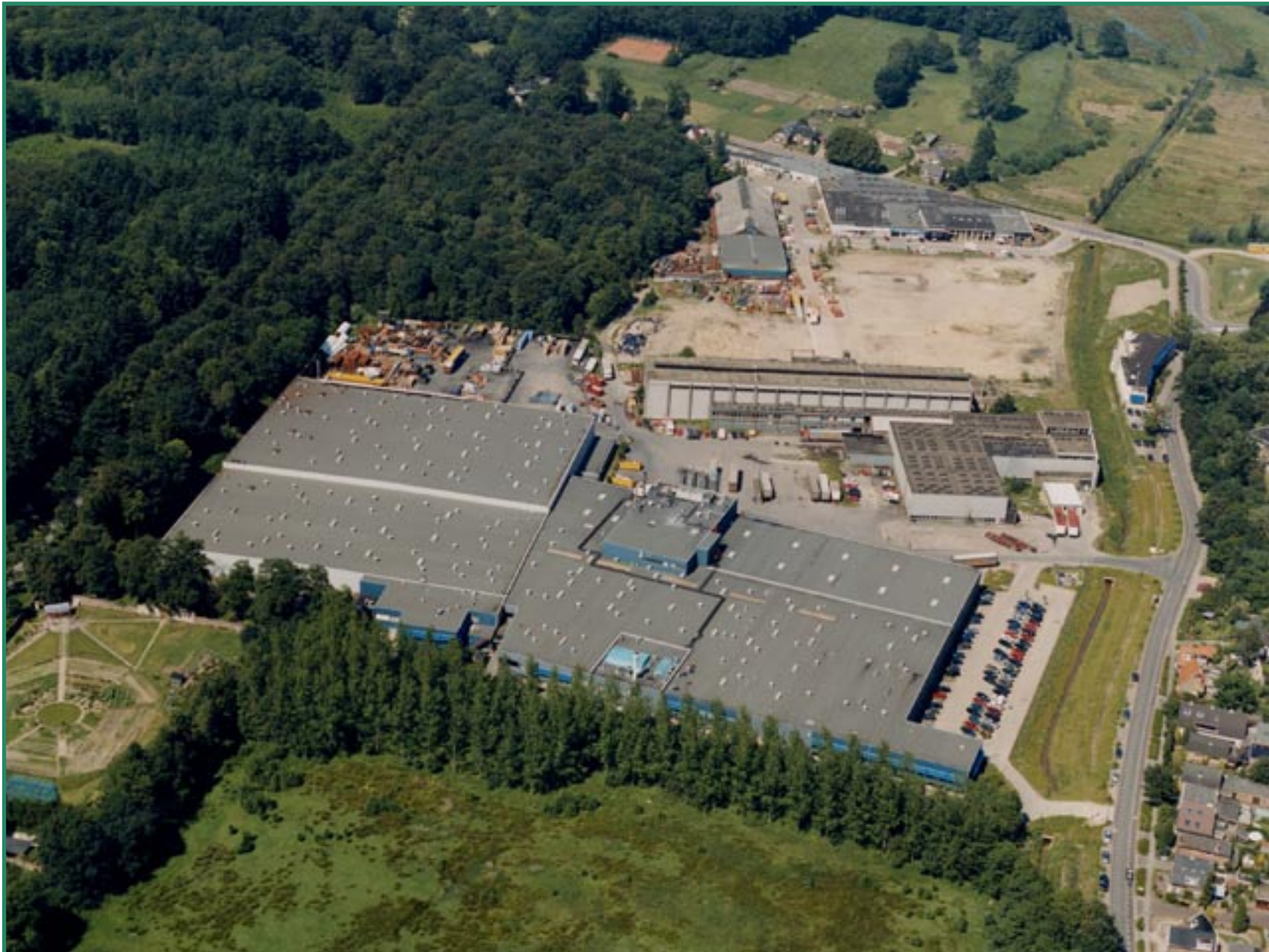
huidige situatie (luchtfoto Pandion)
