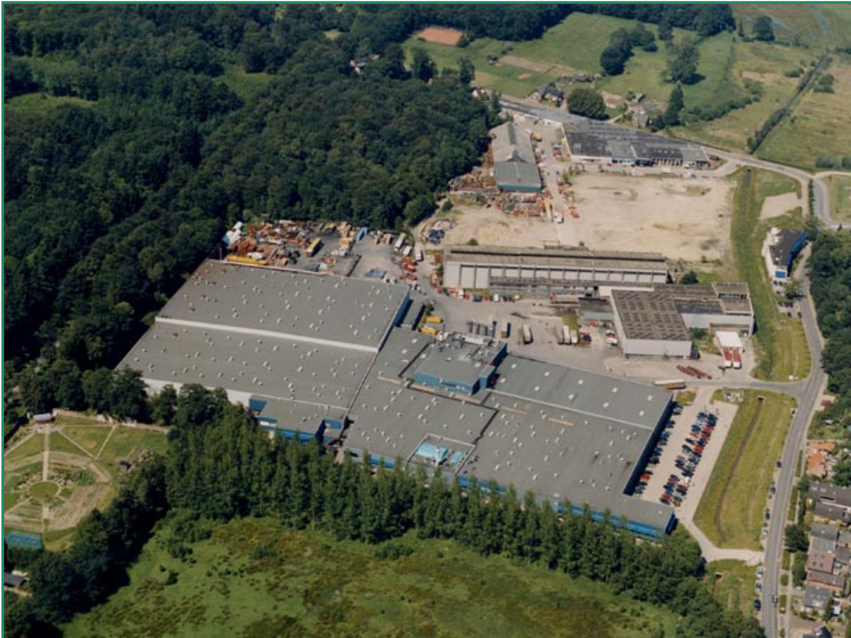
bedrijventerrein Beukenlaan in het Renkums beekdal (luchtfoto Pandion)
