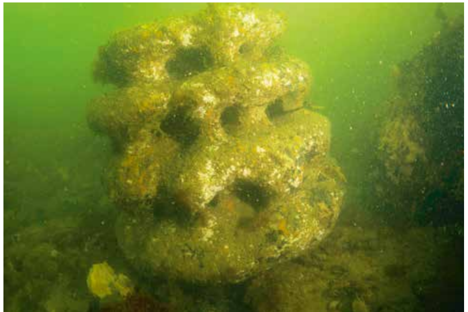
Foto 4. Bij de Blokkendam in de Voordelta zijn 3D-geprinte riffen geplaatst, waaraan oesters en mosselen zich kunnen hechten. (Foto: Oscar Bos)
