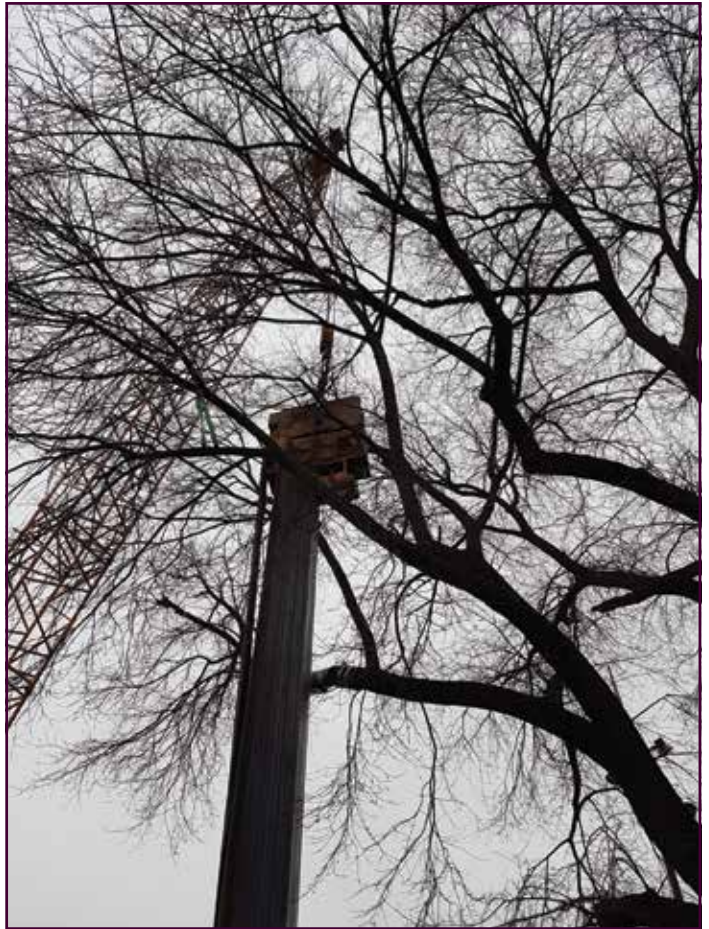
Het ruim 3 m hoge en 5 ton zware trilblok is meerdere keren op een andere plek en hoek op het profiel gezet om zonder schade naar beneden te kunnen zakken tijdens het trillen.
