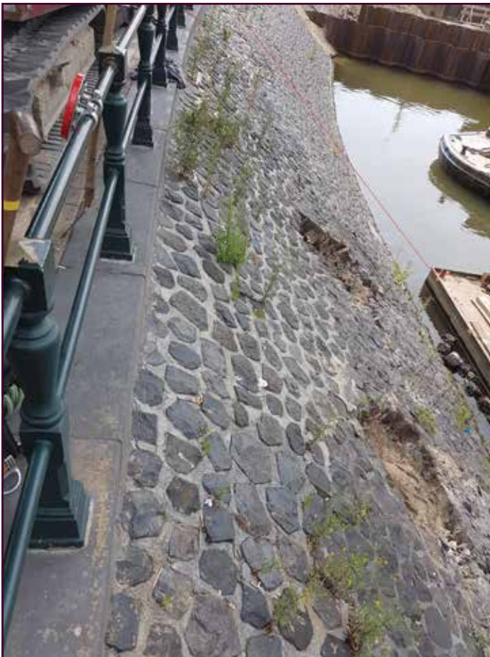
Ter hoogte van de boom en 3 m verderop zijn openingen in de basaltblokken gemaakt om profielsleuven te graven.
