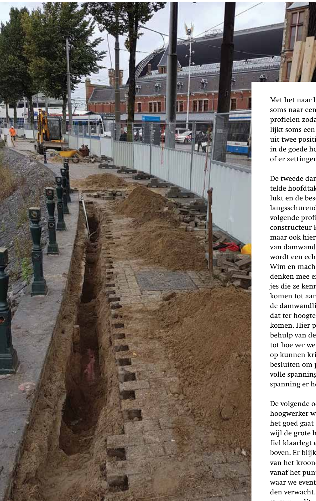
Lange proefsleuf op de lijn waar een tijdelijke grondkering moest komen om afzakken van de kade tijdens het plaatsen van de damwand te voorkomen.
