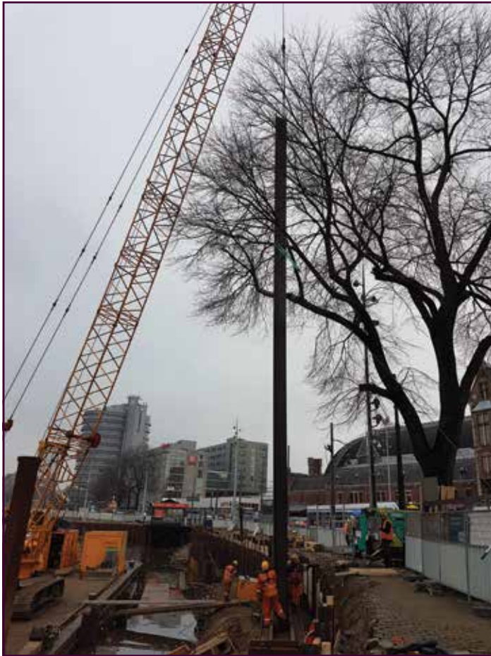
De foto geeft een idee van de dimensie van het werk met de 22 m lange damwandprofielen die door de kroon van de boom heen moesten worden gemanoeuvreed.
