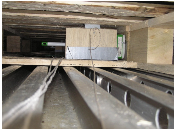
Foto 3: Klep die dmv. een touwtje geopend kan worden, gemonteerd in een palletopening.
