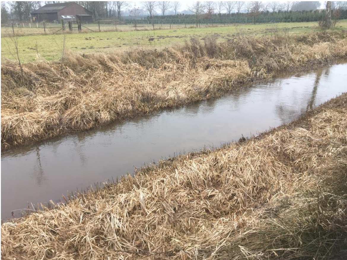
Figuur 2.1. Stroombaanmaaien in de Reusel. In het najaar is alleen de stroombaan gemaaid, de rest van de beek is met vegetatie de winter in gegaan.
