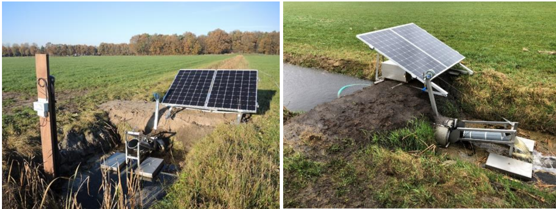
Figuur 2-3: SAWAX-stuw (2.0) bij dhr. Paarhuis te Stegeren. De stuw kan het peilbeheer in kavelsloten mee laten stijgen en dalen met het door het waterschap gevoerde peil in de benedenstroomse hoofdwatergang. Foto's: Gé van den Eertwegh.
