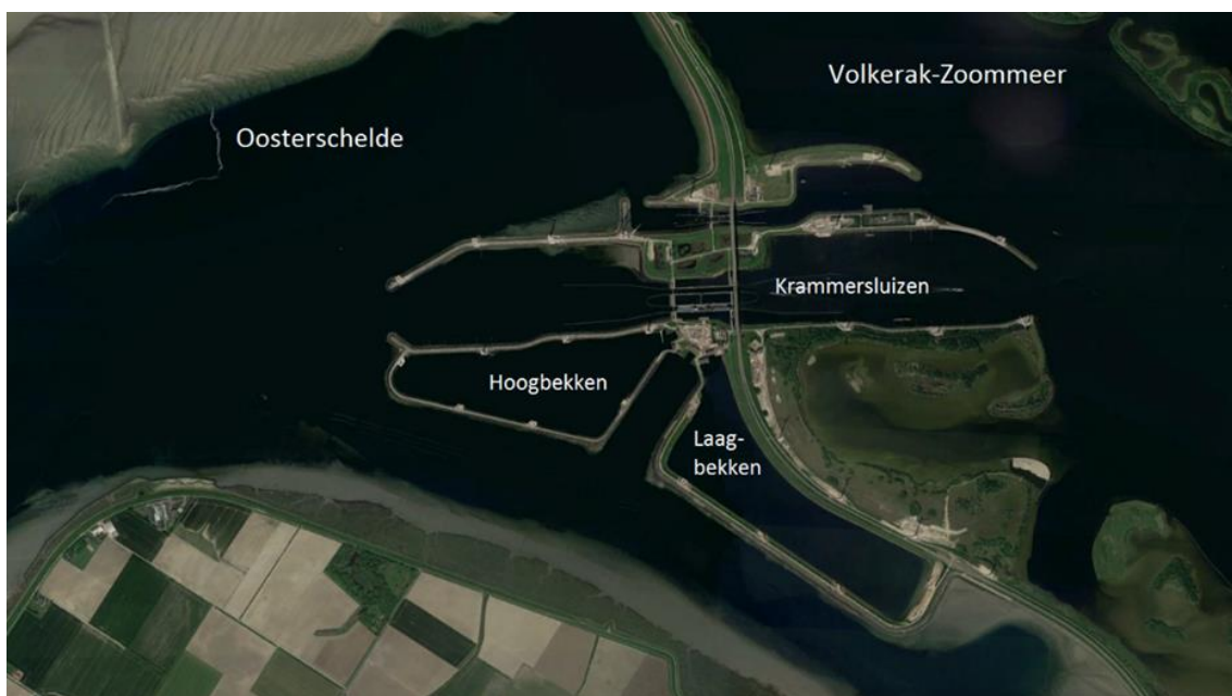
Figuur 1 Locatie Hoog- en Laagbekken van het Krammersluizencomplex.
