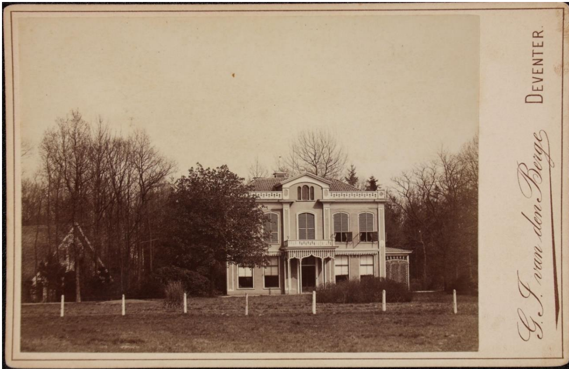
Westgevel in een ander seizoen. (Foto HCO 1096-381). De klimplanten tegen de serre zijn kaal.
