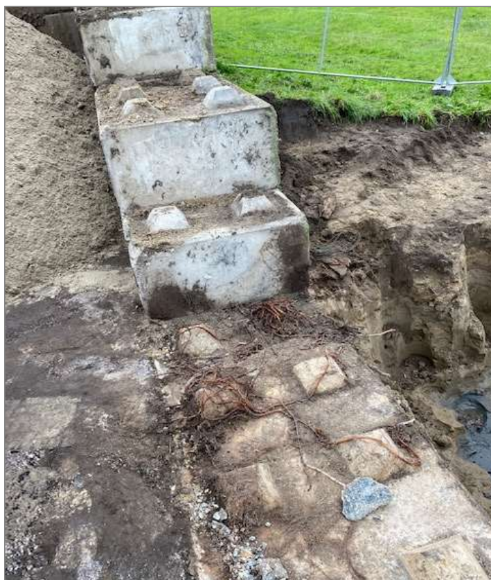
Figuur 11. Afgraaflocatie Oude Maasweg (JDK-76) Duizendknoopwortels zijn door de voegen in een betonnen afscherming gegroeid. Mogelijk is de groeiplaats zelfs vanuit grondstort aan de binnenzijde van de muur begonnen (Foto Iv-Infra)
