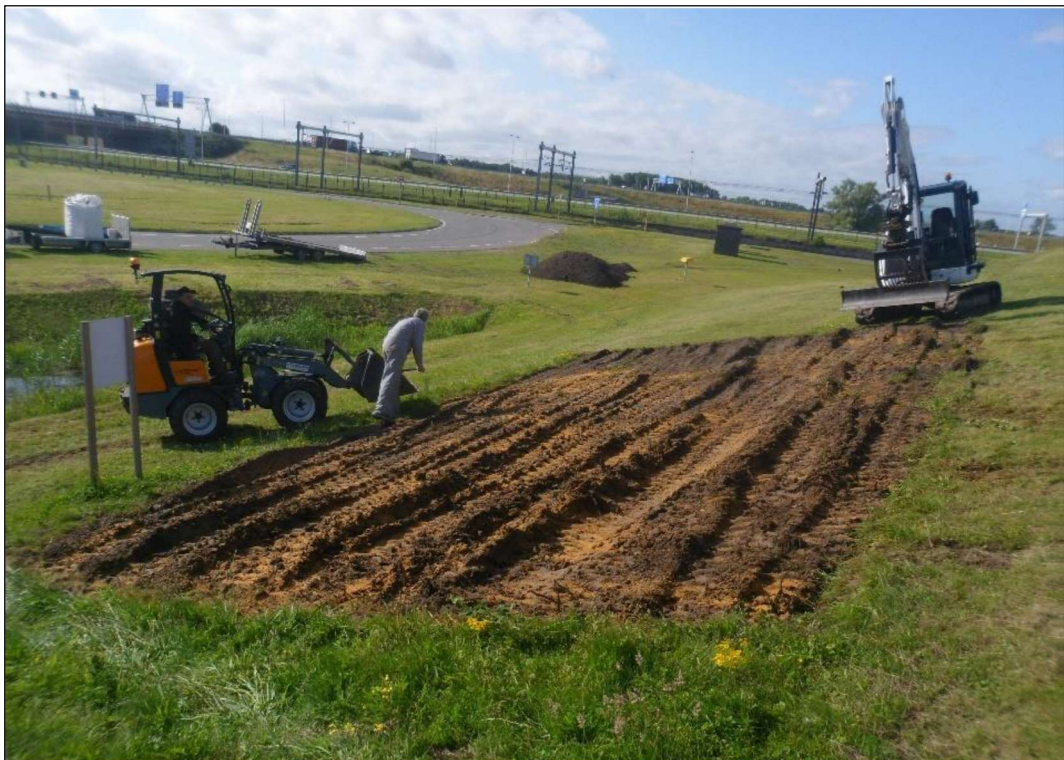
Figuur 17. Aanbrengen van Herbiekorrels op locatie JDK-75 aan de Butaanweg, 7 juli 2020 (Foto Iv-Infra)
