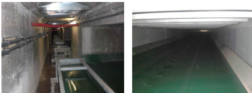
Foto 1 V-vormige mestband. Links: opvang ruimte van urine en feces. Rechts: mestband onder roostervloer (Mosquera et al., 2019).
