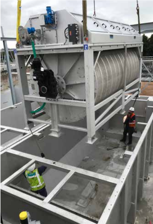
Een trommelzeefinstallatie wordt geplaatst
