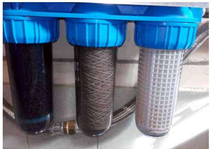
Foto 2: Op het Proefbedrijf Pluimveehouderij zorgden drie filters (van rechts naar links: grofmazige filter, fijnmazig draadfilter, actief koolfilter) voor een eerste filtratie van het regenwater.
