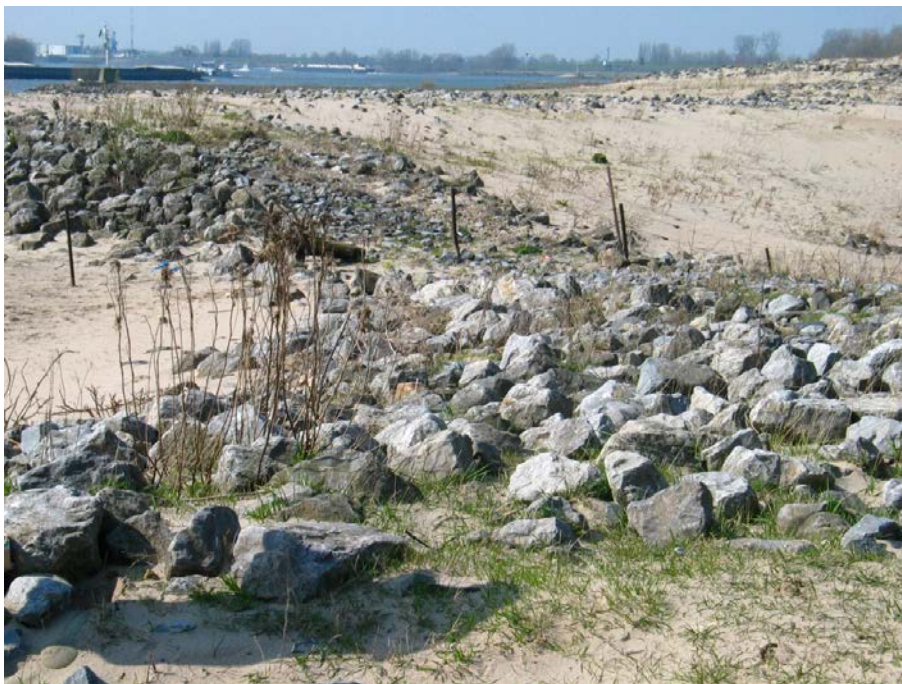
Foto 7 Oude basaltbeschoeiing langs de Waal, bij Millingen (Foto: Theo van der Sluis).
