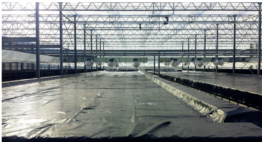
Overzicht van een afgedekte collector. Het water stroomt onder de afdekkende plasticfolie van achteren naar voren.
