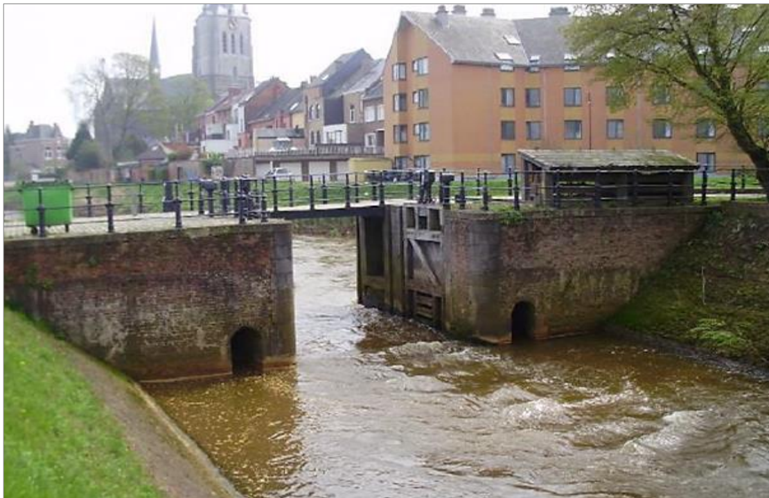
Afb. 5. Het gerestaureerde bovenhoofd van de schutsluis in Aarschot. De draaideuren zijn nu permanent in hun kassen vergrendeld. Noteer de twee kokers (omloopriolen) aan weerskanten in het sluishoofd. Ze waren voorzien van hefschuiven die toelieten de sluiskamer te vullen eens de deuren gesloten waren. Rechts zien we de houten luifel waaronder de schotbalken opgeborgen zijn om ze droog en uit de zon te houden wanneer ze niet gebruikt worden. Als de Demervallei stroomopwaarts onder water zou gezet zijn, zou het water over de landhoofden gestroomd hebben.
