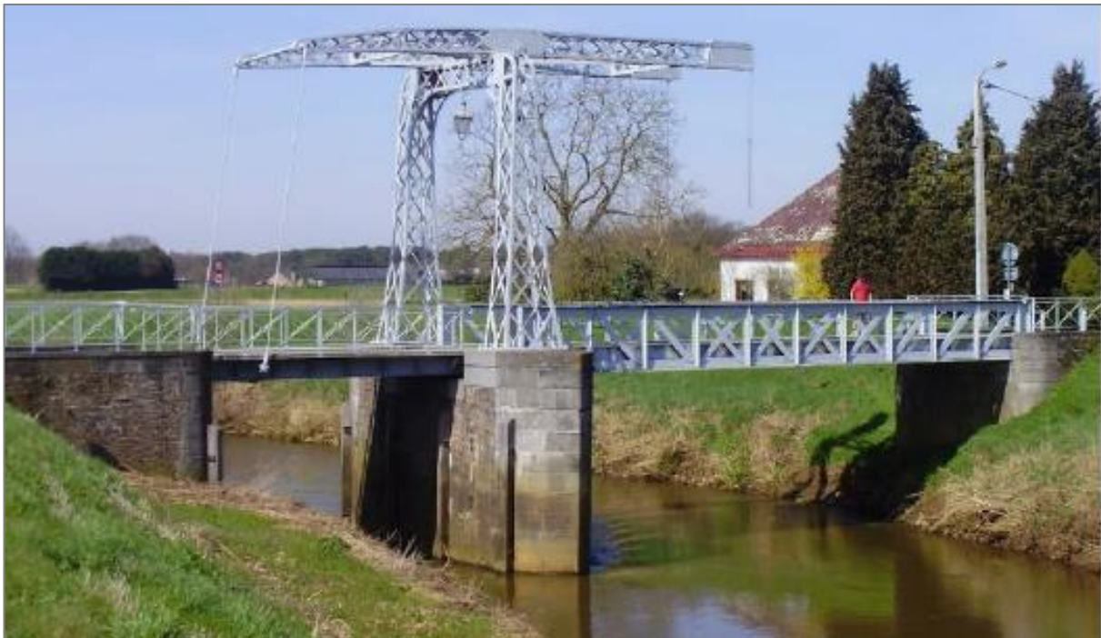
Afb. 12. De Hansbrug is gereconstrueerd volgens haar oorspronkelijke staat. Dit is een stroomafwaarts gezicht met de vaargeul aan de linkerzijde van de pijler. Het verkeer is vandaag beperkt tot voetgangers, fietsers en motorfietsen. Een moderne brug stroomopwaarts leidt het hedendaagse verkeer om.
