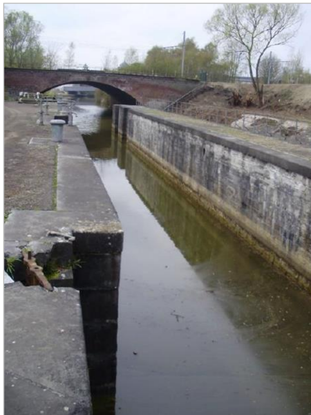
Afb. 2. De Bovensluis - ook Roestenbergsluis genoemd - bestaat nog steeds, maar werd buiten gebruik gesteld. Hier kijken we in de richting van Mechelen met op de achtergrond de spoorwegbrug op de lijn Mechelen-Leuven. Noteer de beide deurkassen aan het einde van de sluis muren en één op de voorgrond. Het bovenhoofd van de sluis - achter de fotograaf - is vandaag afgesloten.
