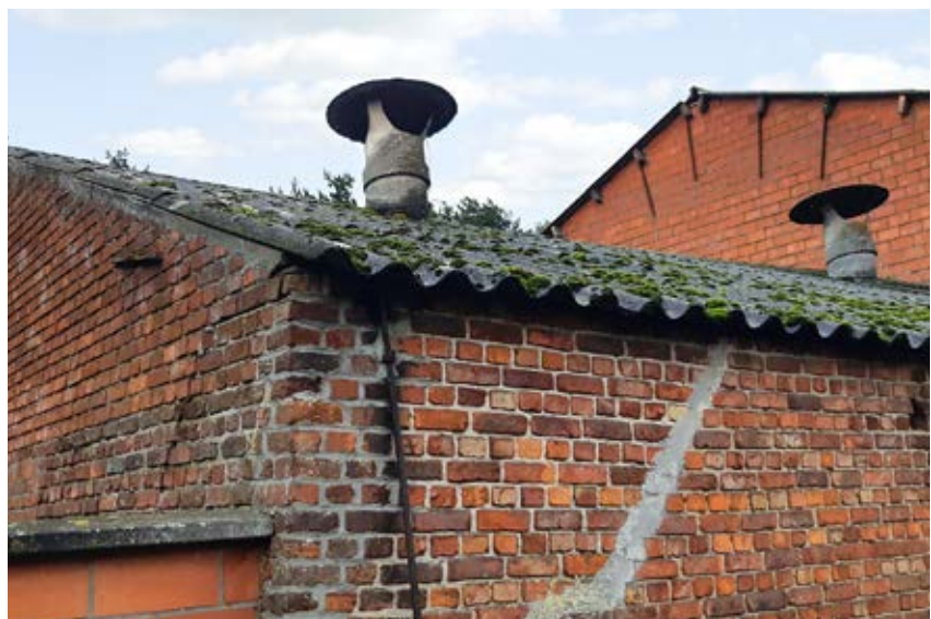
Door verwerking kan asbest vrijkomen uit golfplaten en in de bodem te vinden zijn ter hoogte van zogenaamde afdrui- of grenszones.
